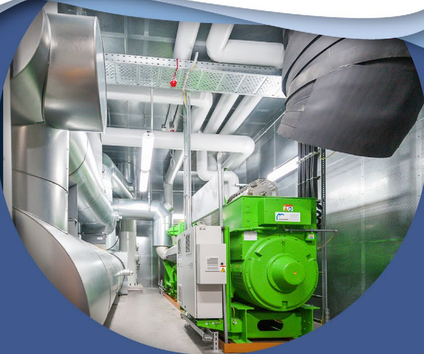
Grafik 22: Blockheizkraftwerk in Lahr/Deutschland
