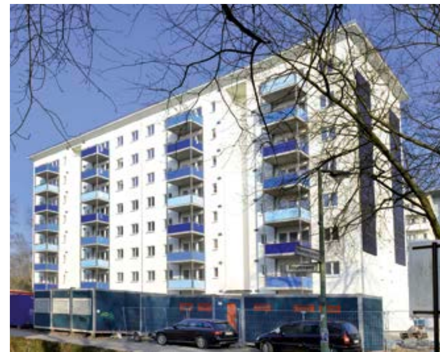
Im Rahmen der Sanierung wurden die vorhandenen Balkone abgesägt und entfernt. Die neuen Balkone wurden vor die Fassade gesetzt, damit sie thermisch vom Gebäude getrennt sind.
