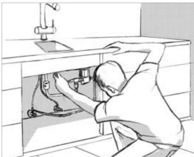
3. 和平时一样,将配件连接到水管接口。现在把EasyTouch技术的电池供电控制器连接到配件和冷水水管接口之间安装结束。
