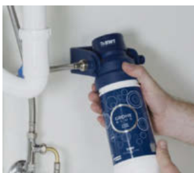
Przymocuj uchwyt do filtra do szafki i przykręć filtr do głowicy filtra. Następnie przyłącz filtr do dopływu zimnej wody.
