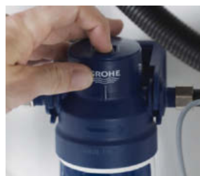
Ustaw obejście głowicy i licznik przepustowości zgodnie z twardością wody.
