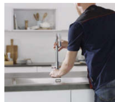
Plasser servanten og monter med monteringssettet under vasken/skapet.
