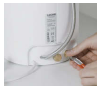
Koble berederen til sikkerhetsenheten og servanten. Deretter åpner du vinkelventilene før du kobler til strømforsyningen.
