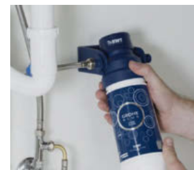
Fest filterholderen til skapet og skru filteret i filterhodet. Koble deretter filteret til kaldtvannforsyningen.
