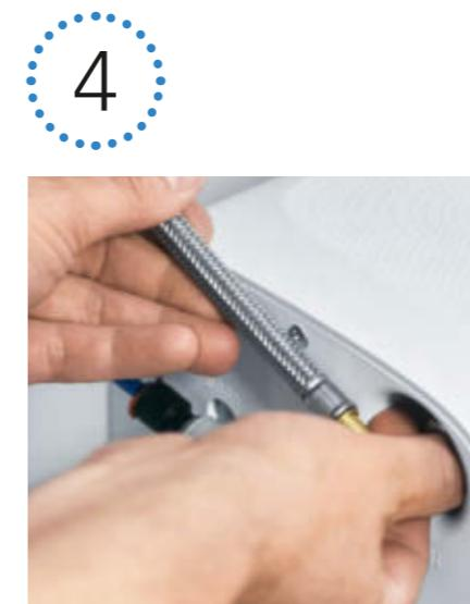
Skru inn filteret i filterhodet og plasser kjøleren under skapet ved boret hull. Deretter konfigureres filter-vannet (uten CO2-flaske installert) sammen med servantens trykknapper.
