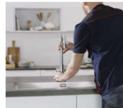
Plaats kraan en monteer met fixatie-set onder de kast.
