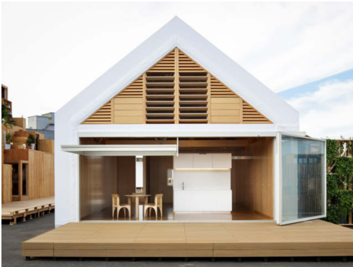
Finestre con apertura meccanica basculante creano l'apertura che dà il nome alla casa di Shigeru Ban.
