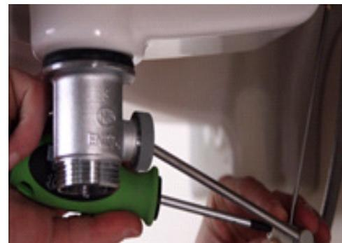
Vérifiez le bon fonctionnement de la tirette de vidage. Prenez le clapet. En actionnant la tirette de vidage, vérifiez que le clapet se ferme totalement. Si ce n'est pas le cas, retirez-le et desserrez le contre-écrou, vissez la vis de réglage avec une clé à molette, et resserrez, avec une clé plate de 10 mm, le contre-écrou.
