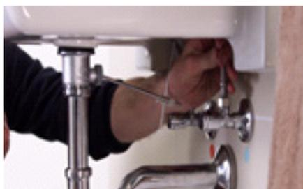
Vissez le flexible gauche sur le robinet d'eau chaude et le droit sur le robinet d'eau froide.
