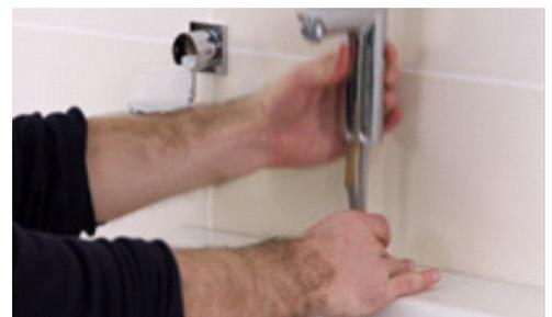
Prenez la cale de serrage et son écrou. Glissez maintenant la cale de serrage le long de la tige filetée en positionnant le joint vers le support puis vissez manuellement l'écrou au maximum.
