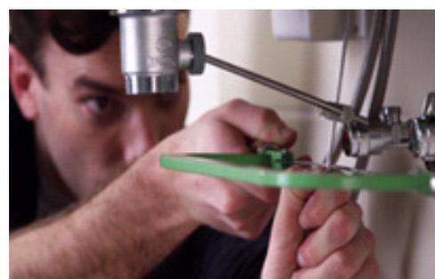
Raccordez la bonde avec le siphon puis vérifiez la bonne mise en place des joints. Serrez à la main.
