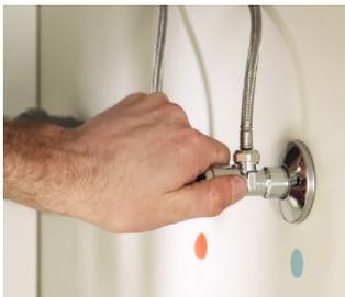
Vérifiez qu'aucun obstacle ne gêne la bonne circulation du flexible de la douche extractible. Ouvrez les deux robinets d'arrivée d'eau et vérifiez la bonne étanchéité des robinets.
