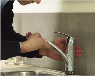
Posez le robinet de sorte à ce que le joint d'étanchéité fasse contact avec l'évier sans sortir de la rigole. Maintenez le robinet dans cette position.
