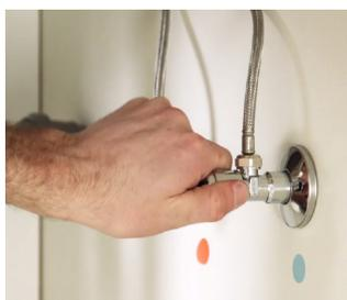
Ouvrez les deux robinets d'arrivée d'eau et vérifiez la bonne étanchéité des robinets.
