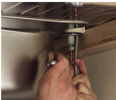
Tenez le robinet et à l'aide d'une clé plate de 13 mm, serrez l'écrou sans forcer.
