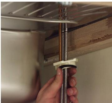
Insérez la bague de stabilisation par les flexibles puis le long de la tige filetée. De la même manière, insérez le joint de serrage et enfin, la cale de serrage. De vos doigts, vissez l'écrou au maximum.
