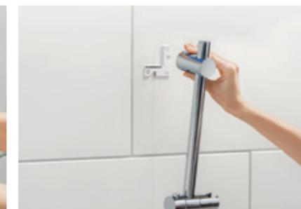
Monter les supports sur la barre et l'apposer au mur.
