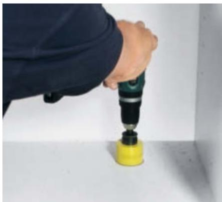
Positionnez le gabarit de perçage et percez les trous de ventilation comme il convient.
