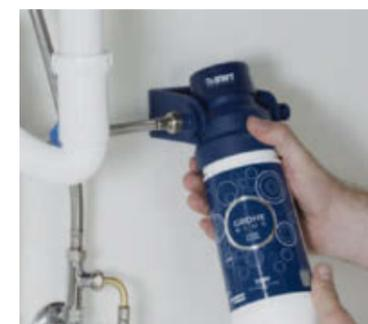
Attachez le support du filtre au meuble et vissez le filtre sur la tête du filtre. Ensuite, raccordez le filtre à l'alimentation en eau froide.
