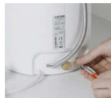
Connectez le boiler au groupe de sécurité et au robinet. Ensuite, ouvrez les valves d'angle avant de connecter l'alimentation électrique.
