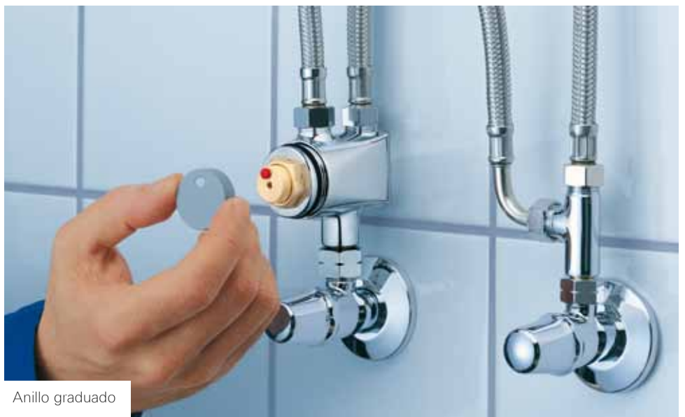
Ajuste de temperatura mediante llave Allen
