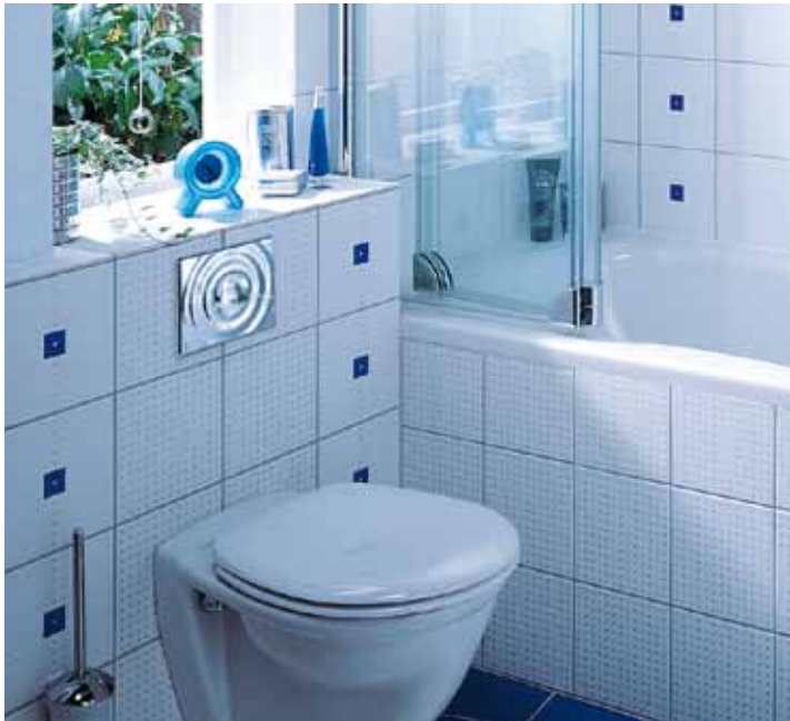
WC con el módulo debajo de una ventana.
