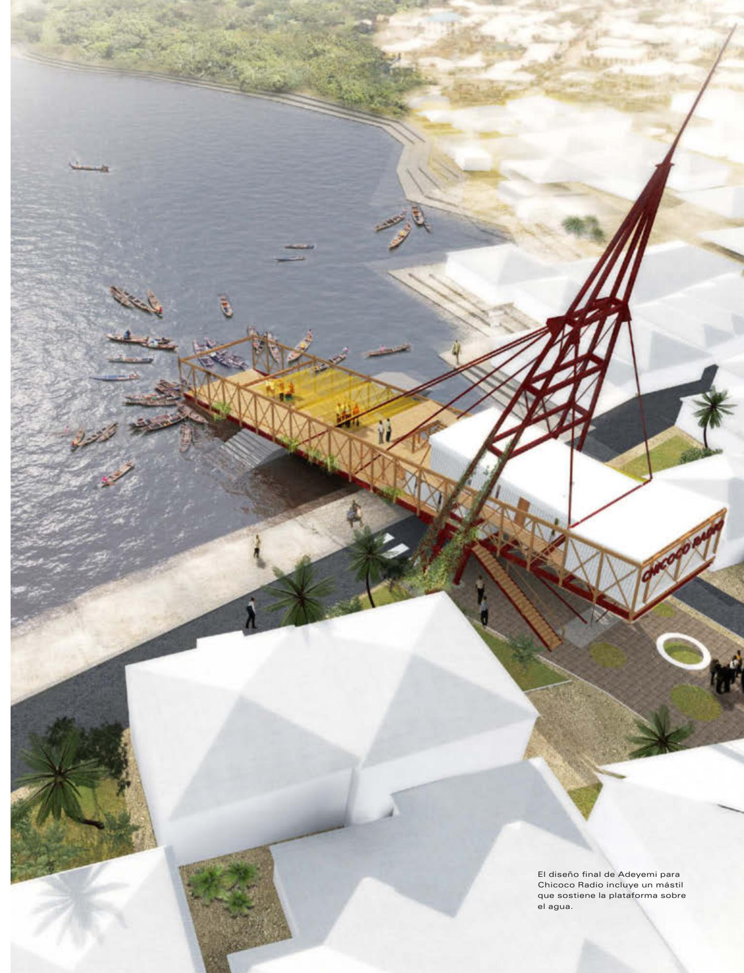
El diseño final de Adeyemi para Chicoco Radio incluye un mástil que sostiene la plataforma sobre el agua.
