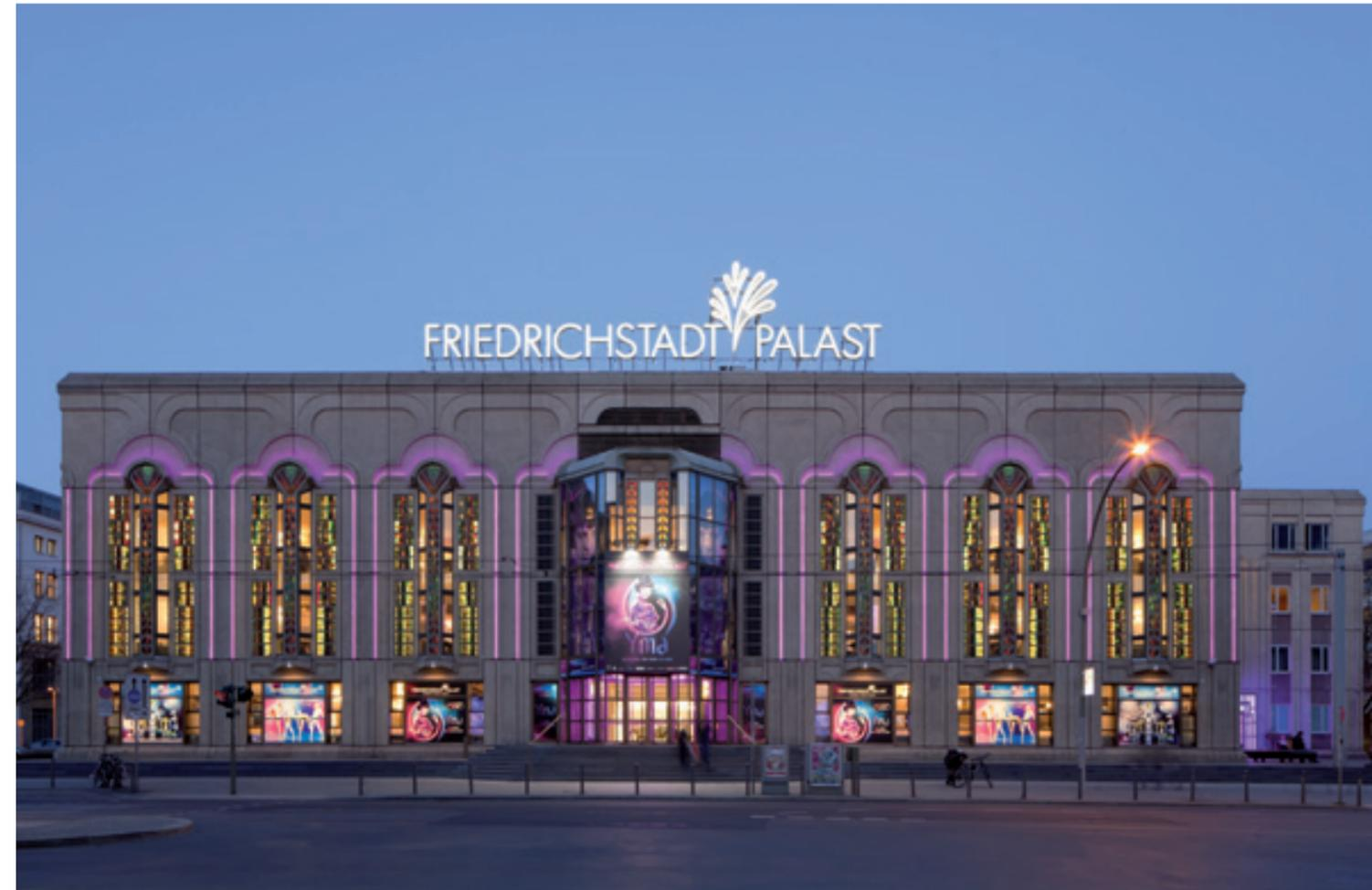
Großformatige Betonwandplatten mit einem besonderen Relief prägen den postmodernen Stil des Friedrichstadt-Palastes
