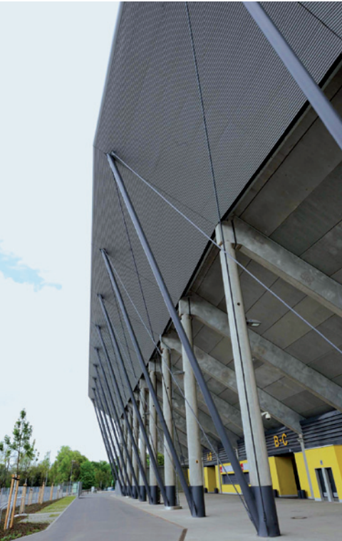
Die Rückseite des Stadions wirkt durch die Betonpfeiler und stählerne Dachkonstruktion nüchtern
