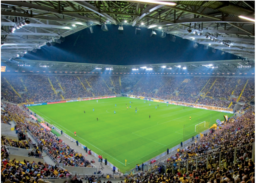
FIFA und UEFA gerecht: Die Stufen der Stehplatztribüne sind so ausgebildet, dass sie als Sitzplatztribüne ausgebaut werden können
