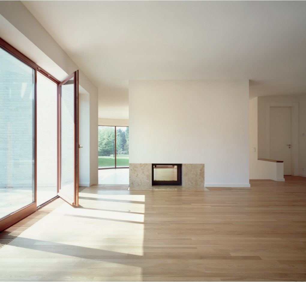
Die Wohn- und Schlafräume wurden mit Eichenholzmassenbretterdielen versehen
