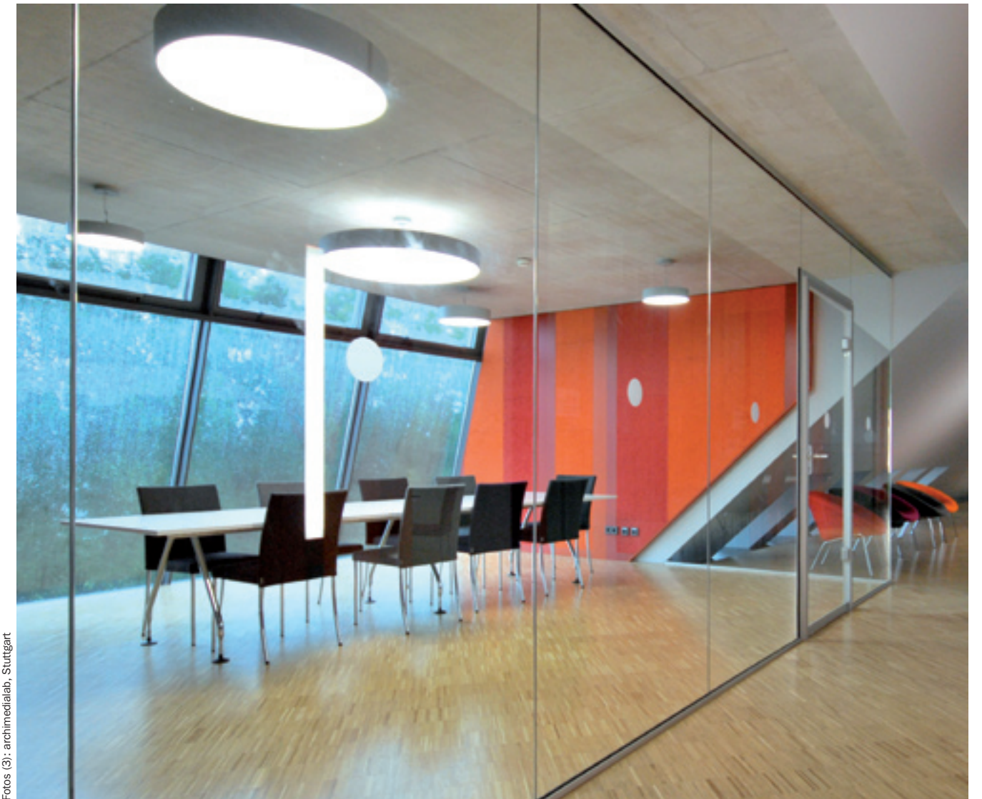
Die Trennwände zwischen Büros und Korridor bestehen aus 2-schaligen Profilglaselementen
