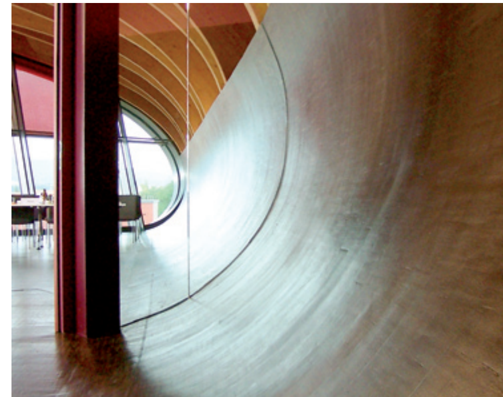
Das Parkett der oberen Ebene nimmt die Biegung der Holzkonstruktion auf
