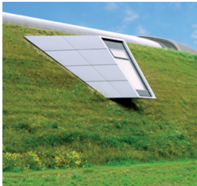
Tagungsräume und öffentliche Bereiche durchdringen den Erdwall, um eine Beziehung mit dem angrenzenden Dorf herzustellen
