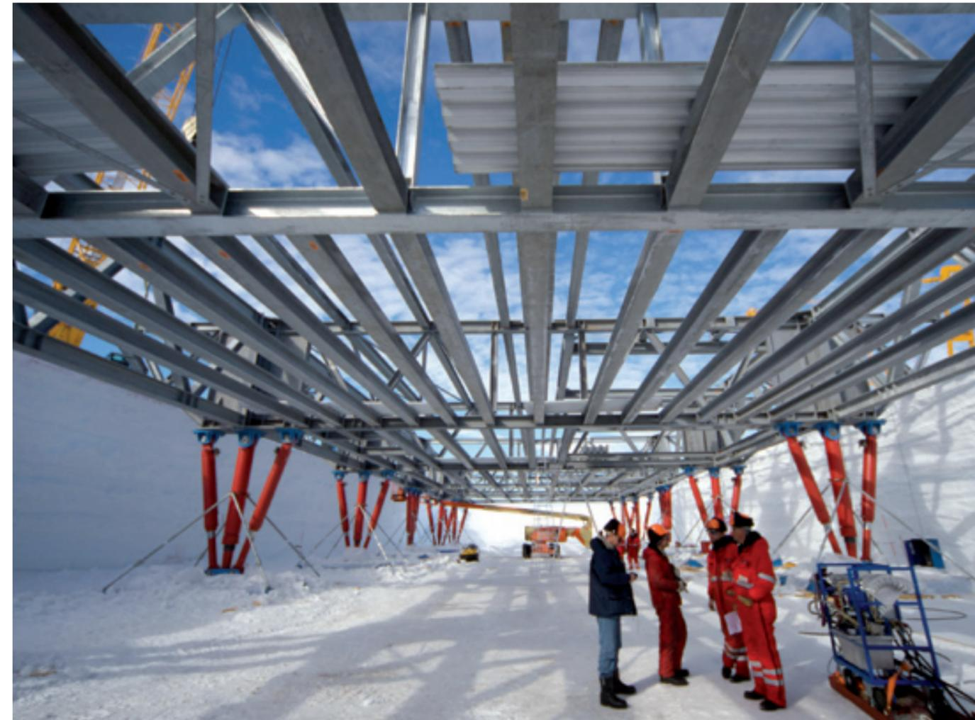
16 hydraulische Hebevorrichtungen verhindern, dass die Station im Schnee versinkt
