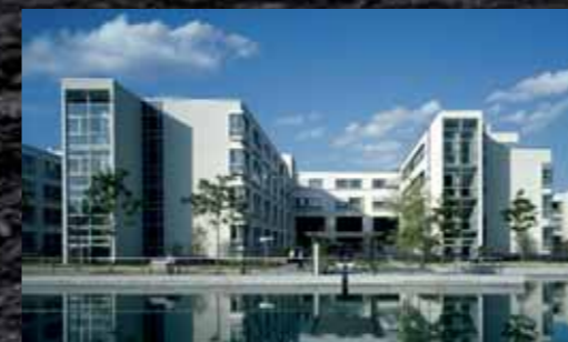
St. Johann Nepomuk Klinik | Erfurt Architekt | TMK Architekten/Ingenieure
