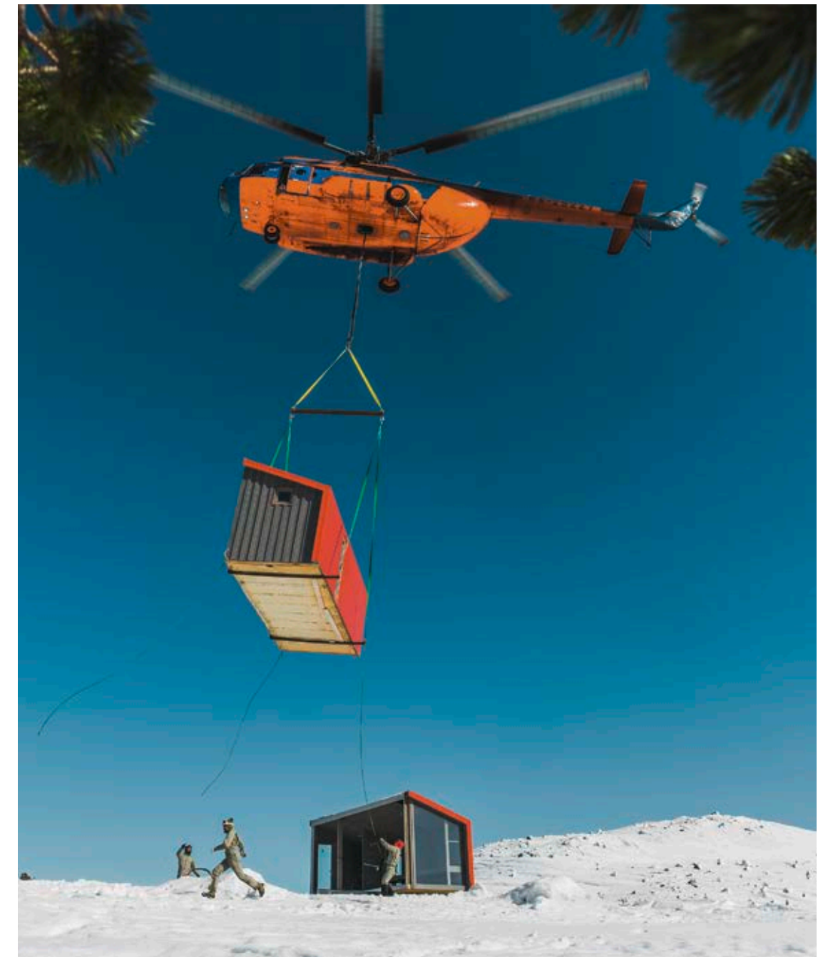
Planung ist alles: Ein Jahr dauerte die Vorbereitung, die Installation hingegen gerade einmal 45 Minuten. Um die DublDom-Module anzuliefern, musste der Helikopter nur zweimal fliegen.
