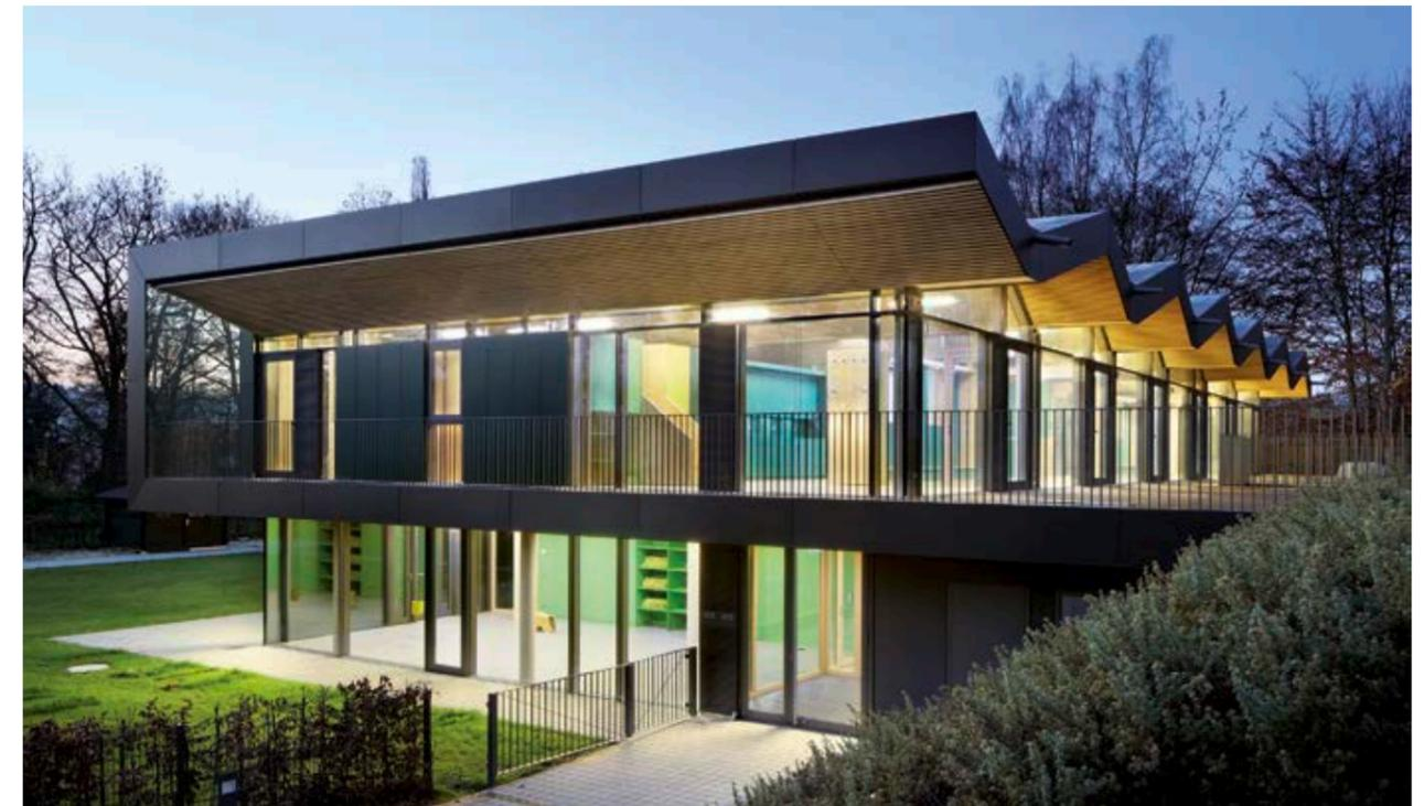
Während des Entwurfsprozesses stellten die Architekten und Energieplaner fest, dass sich die Ausrichtung der Solarmodule mit einem „ziehharmonikaartigen Bauvolumen“ in Dach und Südwestfassade optimieren und die solaraktive Oberfläche vergrößern lassen würde. So entstand das charakteristische Faltwerk des Baukörpers, das nicht nur das Erscheinungsbild bereichert, sondern auch eine differenzierte Innenraumgestaltung und -wahrnehmung ermöglichte.
