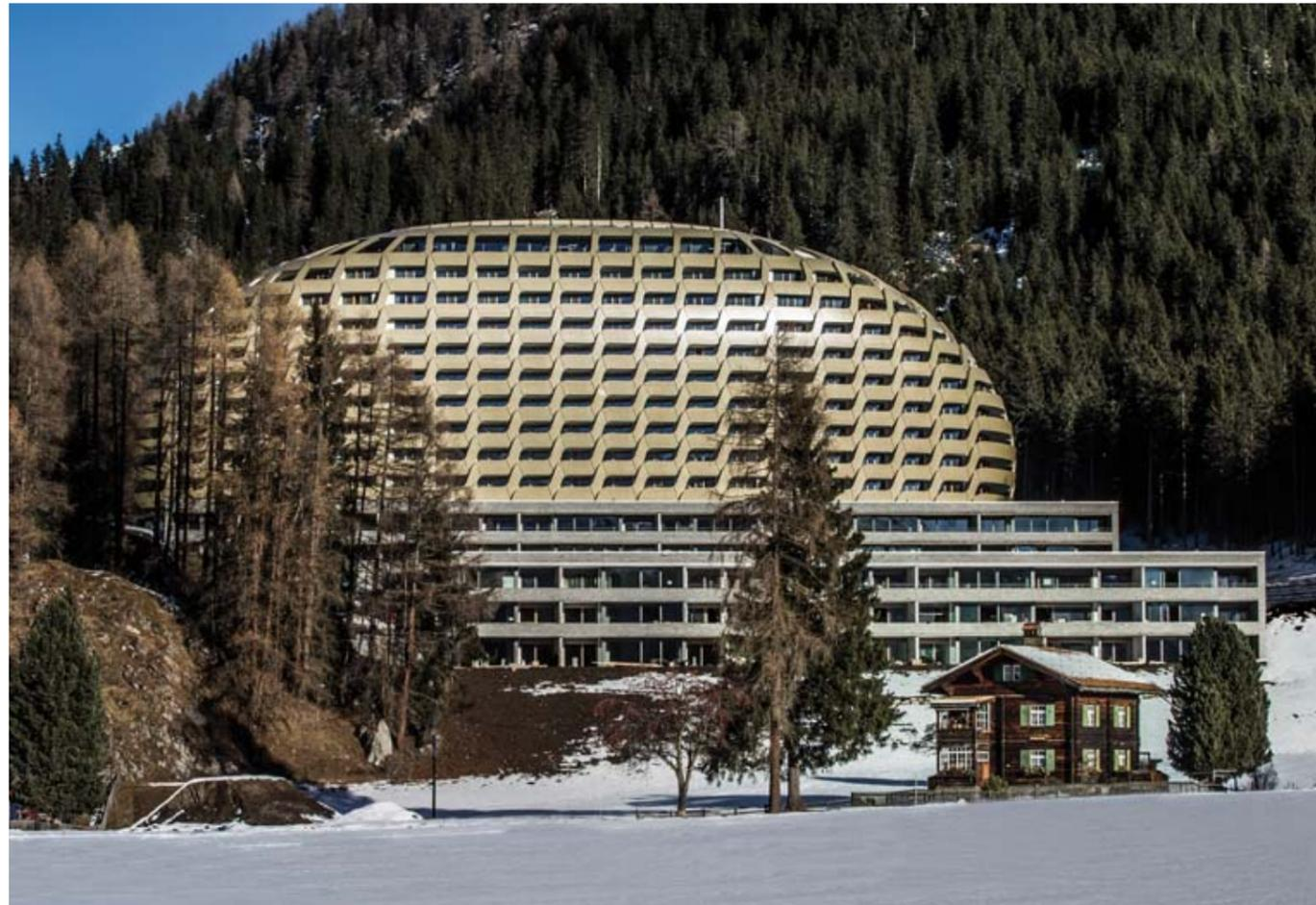
Die schimmernde Fassadenverkleidung des 42 Meter hohen Luxushotels in Davos besteht aus wellenförmigen Modulen aus Stahl, die um die zehn Stockwerke der Struktur installiert wurden. Verdeckte Anschlüsse in Edelstahl und ein aufwändiges Beschichtungssystem mit einer speziell entwickelten Nassbeschichtung sorgen für das glatte Erscheinungsbild.
