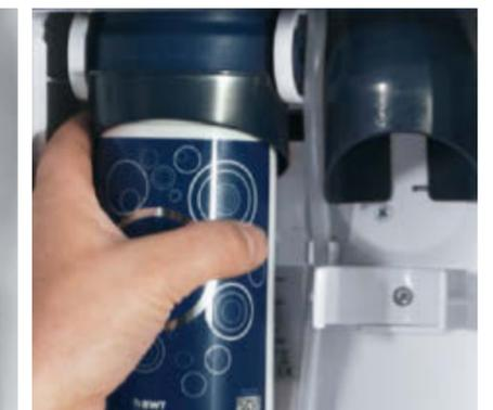
Avvitare il filtro nell'apposita testata e posizionare il refrigeratore in corrispondenza degli appositi fori.
