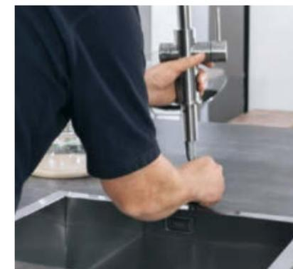
Posizionare il rubinetto e fissarlo nella parte inferiore con il set d'installazione.
