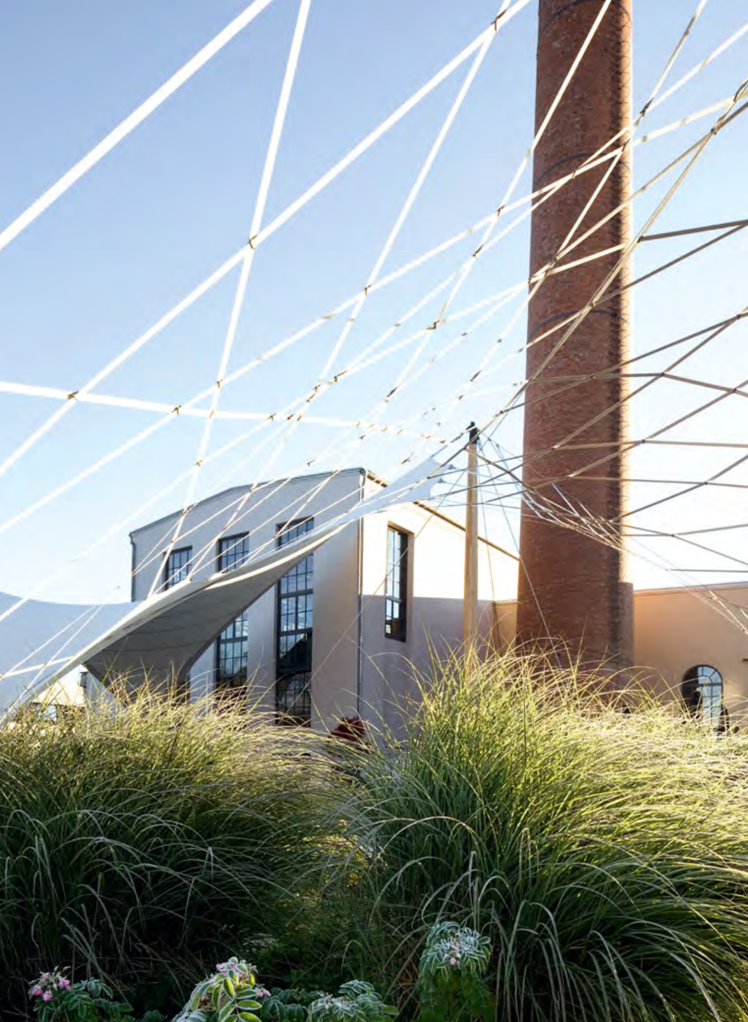
Das Kesselhaus bildete einst zusammen mit dem Turbinenhaus die Energiezentrale der Baumwollspinnerei. Heute befinden sich darin Veranstaltungsräume (siehe Bild rechts).
