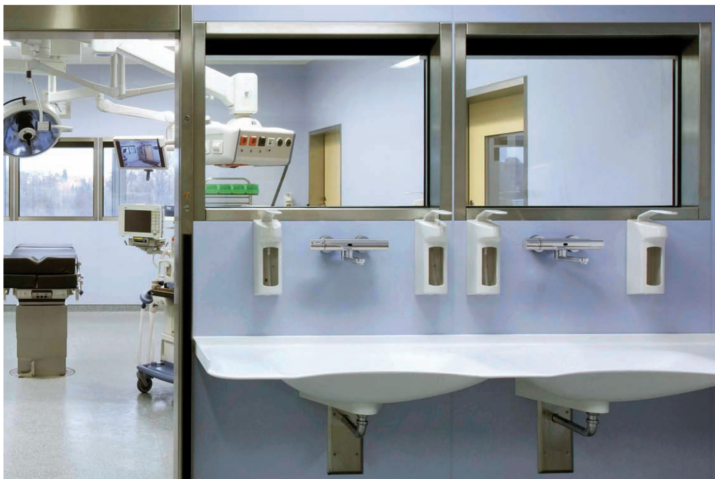
Splňuje nejvyšší hygienické nároky: termostatická umyvadlová baterie GROHE Europlus E s infračerveným elektronickým snímačem Foto © Jochen Stüber, Hamburg
