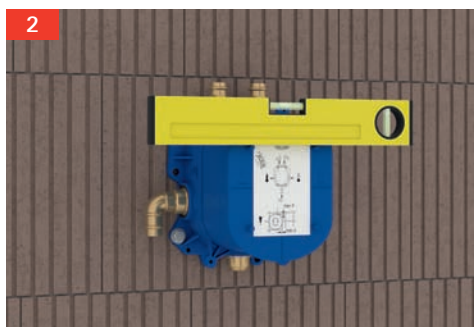
2 Vyrovnajte podomítkový ventil Označte si miesta pro vrtání, vyvrtejte otvory a osadte montážní krabici
