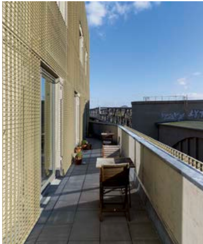
Der Balkon im 5. Stock des östlichen Kopfbaus. Aus der Nähe ist die Gitterstruktur des Fassadenkleids gut erkennbar.
