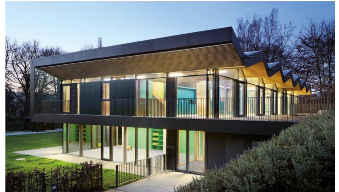
Während des Entwurfsprozesses stellten die Architekten und Energieplaner fest, dass sich die Ausrichtung der Solarmodule mit einem „ziehharmonikaartigen Bauvolumen“ in Dach und Südwestfassade optimieren und die solaraktive Oberfläche vergrößern lassen würde. So entstand das charakteristische Faltenwerk des Baukörpers, das nicht nur das Erscheinungsbild bereichert, sondern auch eine differenzierte Innenraumgestaltung und -wahrnehmung ermöglichte.
