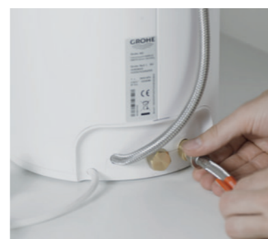
Connectez le boiler au groupe de sécurité et au robinet. Ensuite, ouvrez les valves d'angle avant de connecter l'alimentation électrique.
