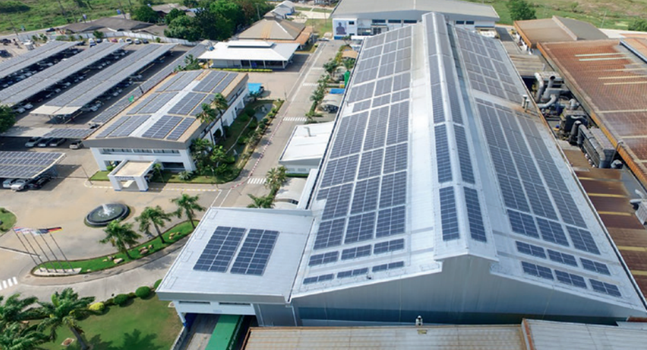
Pannelli fotovoltaici installati sul tetto della fabbrica a Klaeng, che riducono le emissioni di CO 2 di circa 2.000 tonnellate all'anno.
