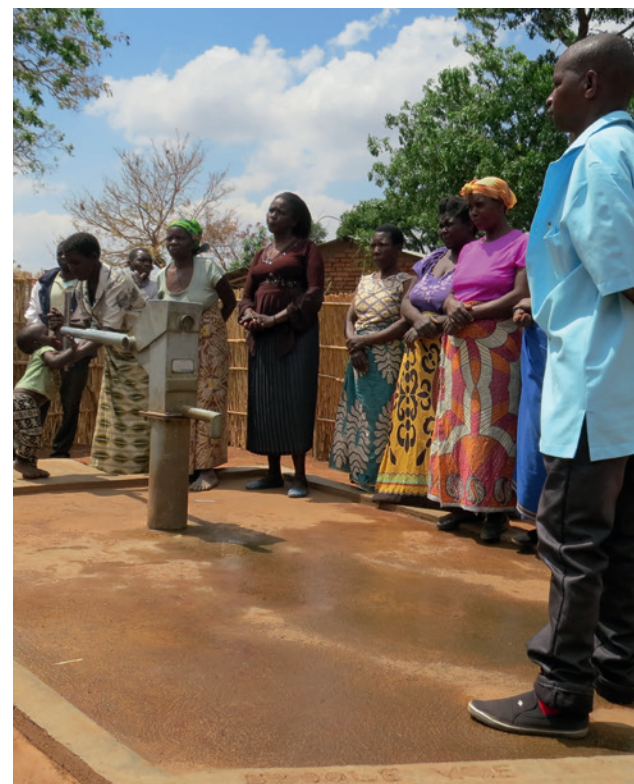
In Malawi GROHE sostiene un progetto di manutenzione dei pozzi danneggiati.
