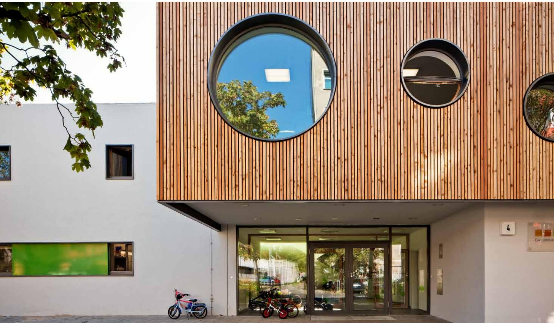
Mit der Sanierung und Erweiterung des aus den 1970er-Jahren stammenden zweigeschossigen Gebäudes gelang den Architekten die Transformation eines gesichtslosen Altbaus in einen markanten, facettenreichen Baukörper. Die Außenwände des Obergeschosses wurden in Kontrast zum Beton des Baukörpers mit farbigen, witterungsbeständigen Paneelen aus Lärchenholz verkleidet.
