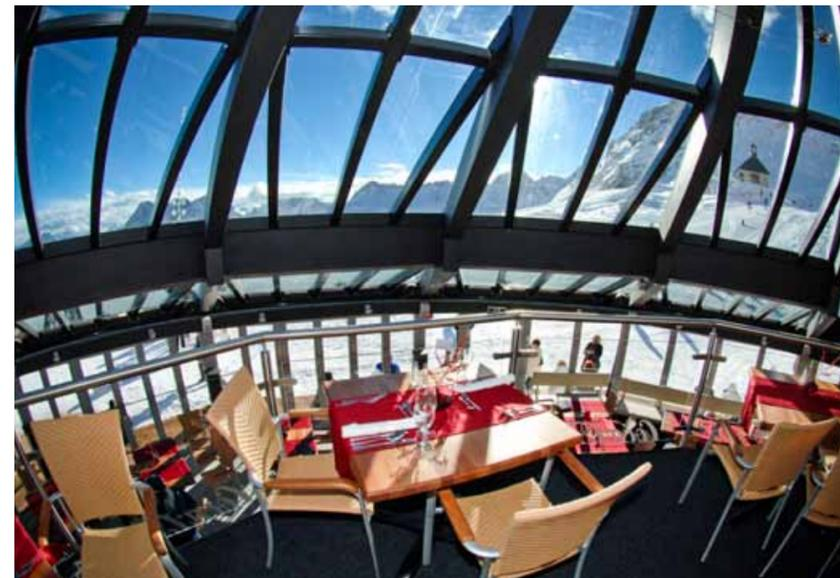
Das Restaurant „Gletschergarten“ mit der raffinierten Gebäudehülle aus Glas und Stahl liegt auf dem Zugspitzplatt in 2600 Meter Höhe. Bei gutem Wetter fährt das Dach fächerartig ein und ermöglicht Gästen einen spektakulären Rundumblick auf das Alpenpanorama. Die hochalpine Lage stellt besondere Anforderungen an die Verglasung. 5 Tonnen speziell an die Bedingungen angepasstes Thermoglas hält die Wärme im Gebäude und bleibt auch bei extremen Minusgraden dicht gegen Zugluft.
