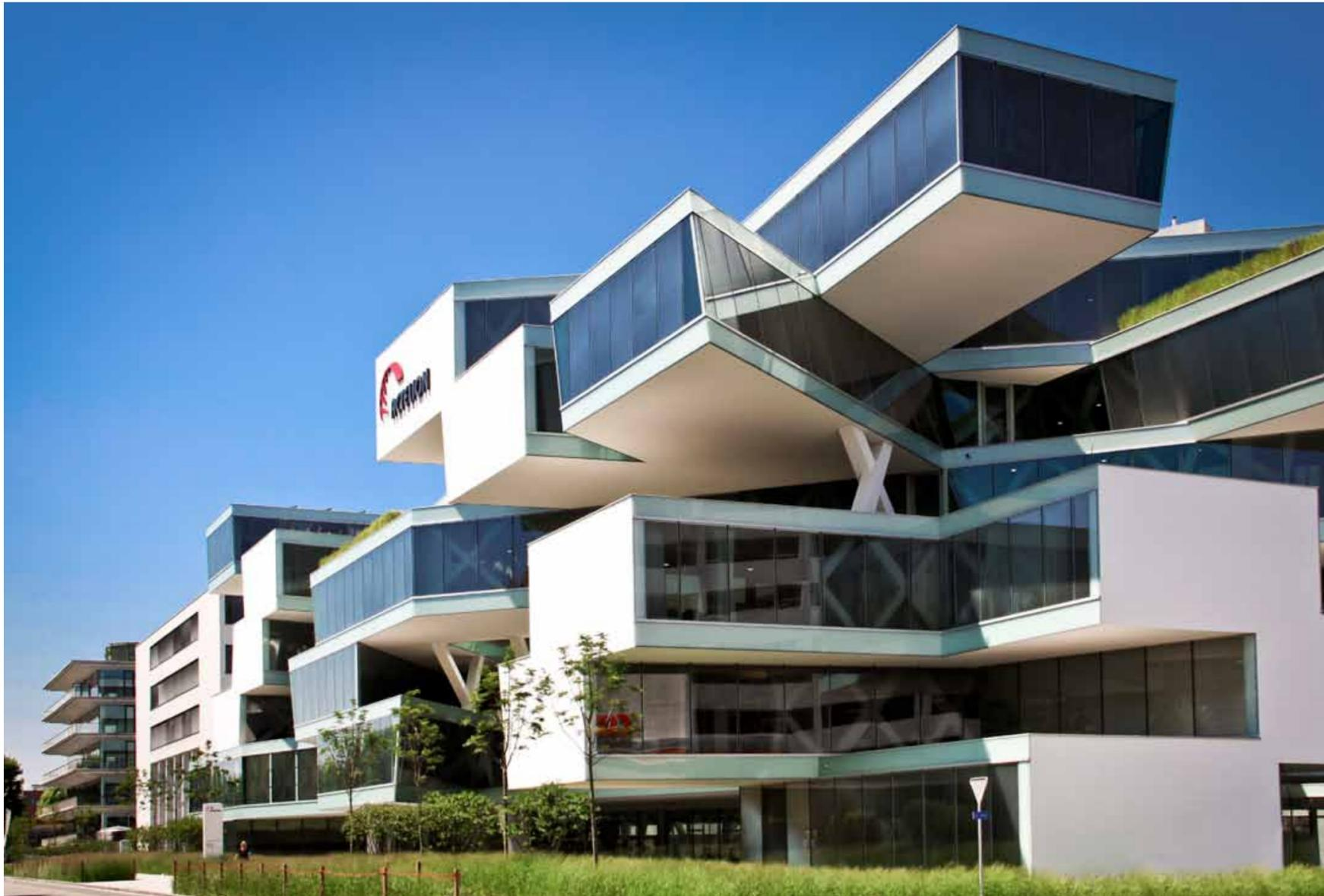
Das fünfstöckige Gebäude besteht aus übereinander angeordneten Baukörpern. Jeweils fünf bis sieben prismatische Körper bilden im Grundriss je ein Geschoss. Jede Geschossebene hat ihr eigenes Trägerlayout und liegt mit seinen auskragenden Elementen nicht deckungsgleich über dem darunterliegenden Geschoss.
