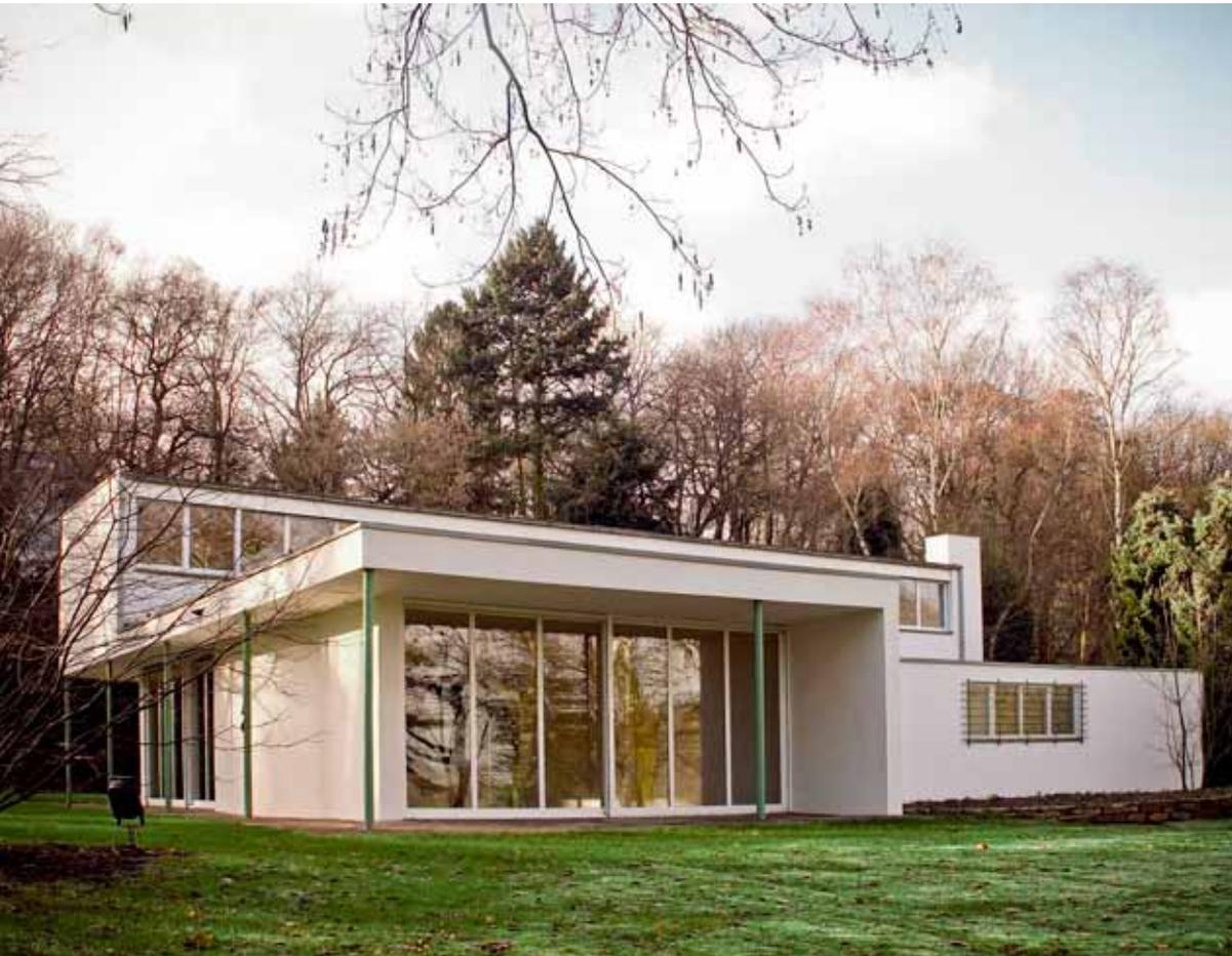
Das in den 1930er-Jahren errichtete Wohnhaus ist heute eine Ikone des Bauhaus-Stils. Ludwig Mies van der Rohe entwarf das Gebäude für die Textilfabrikantenfamilie Heusgen. Der zweigeschossige Bau in Hanglage ist in Stahlskelettbauweise konstruiert. Die dadurch ermöglichte freie Grundrissgestaltung nutzte Mies van der Rohe, um ein Gefüge von ineinander übergehenden Raumzonen im Wohnbereich zu entwickeln.
