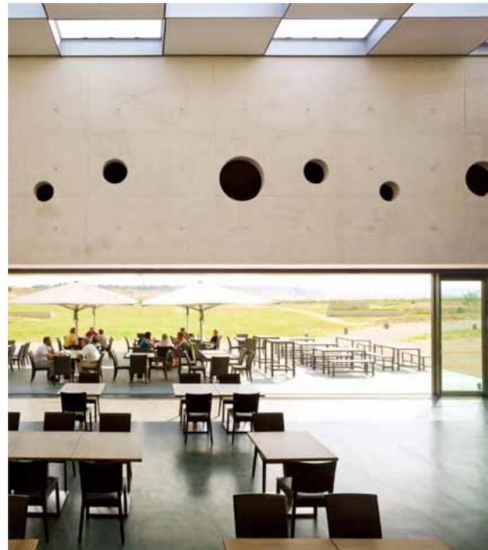
1/ Der für die Fassade verwendete Beton wurde vor seiner Verarbeitung mit unterschiedlichen Farbpigmenten entsprechend den wechselnden Schichtfarben versetzt.
