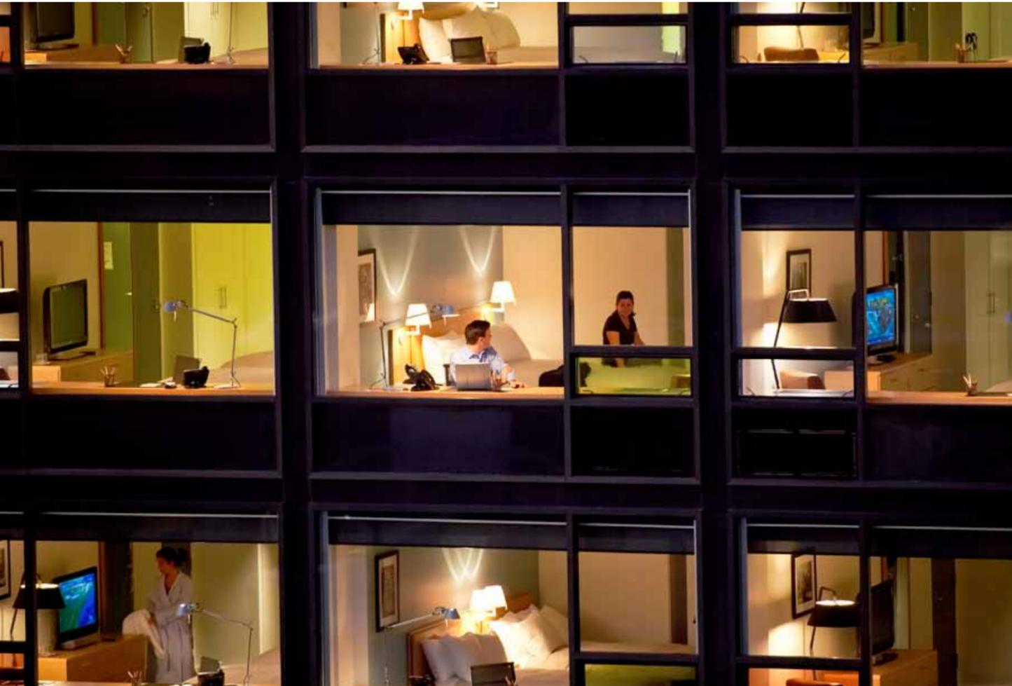
Die Revitalisierung des 1962 erbauten „Colony Inn“ erweitert die Bettenkapazität des in die Jahre gekommenen Hauses und transformiert das Hotel in das moderne „The Study At Yale“. Dazu wurde das ursprünglich 5-stöckige Gebäude um 2 Stockwerke erhöht und mit einer Glas-vorhangfassade versehen, deren Spiel aus Licht und Textur einen Kontrapunkt zu dem Mauerwerk der benachbarten Häuser setzt.
