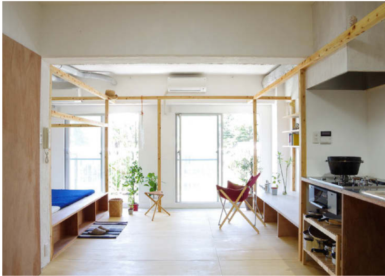
Byt beze stěn má pokoje pouze naznačené pomocí dřevěných příček.
