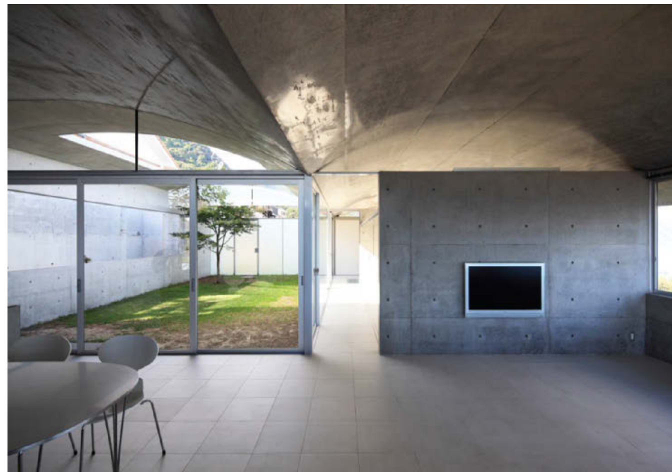
Dům architekta Fujimota v Sunami má zcela holé stěny s výjimkou otvorů v betonu, které vznikly při jeho slévání.
