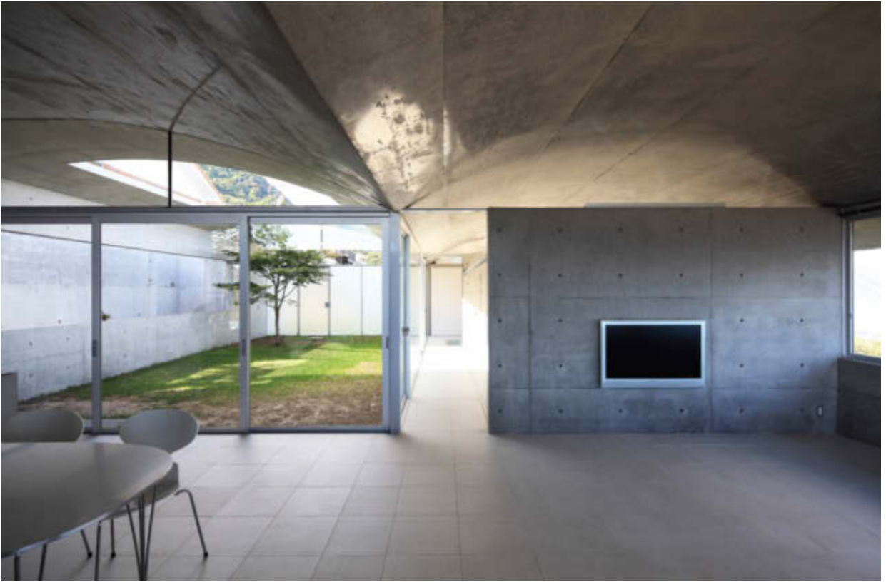
Fujimoto's Sunami huis heeft muren die, behalve de ronde gaten die oorspronkelijk ontstonden bij het gieten van beton, helemaal onbewerkt zijn.
