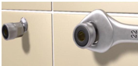
Serrez les raccords excentrés avec une clé plate de 22mm.
