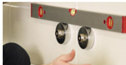
Installez le mitigeur et vissez à fond. Les écrous ne doivent pas toucher les rosaces. Ajustez si nécessaire et revérifiez l'horizontalité.
