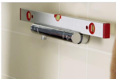
Vérifiez l'horizontalité du mitigeur avec le niveau à bulle. Si besoin, ajustez-le. Vérifiez l'étanchéité des raccords en alimentant le mitigeur.
