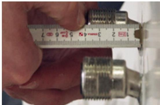
Démontez le tout. Notez la profondeur entre les raccords excentrés et le mur.
