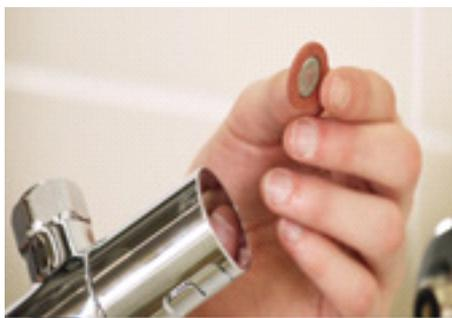
Enlevez les caches rouges et bleus du mitigeur puis contrôlez la bonne mise en place des filtres à impureté, côté bombé vers l'intérieur.
