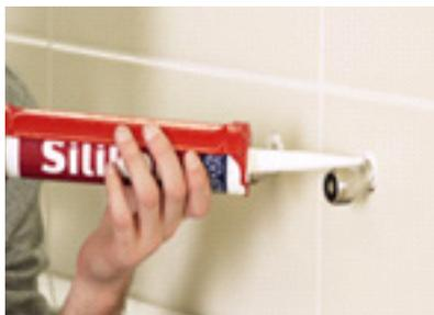
Étalez du joint silicone entre le mur et les raccords excentrés.
