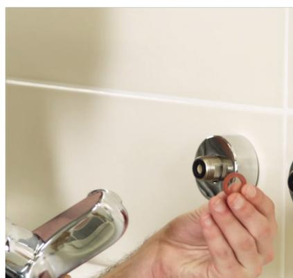
Enlevez les caches rouges et bleus du mitigeur puis contrôlez la bonne mise en place des filtres à impureté, côté bombé vers l'intérieur.
