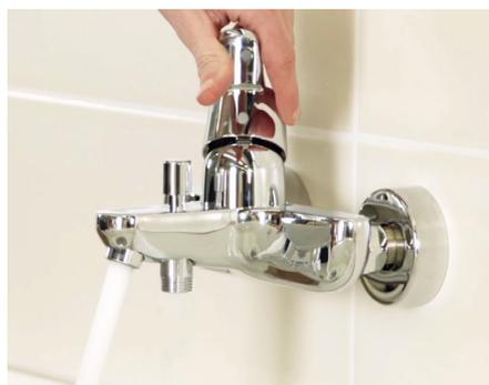
Vérifiez l'horizontalité du mitigeur avec le niveau à bulle. Si besoin, ajustez-le. Vérifiez l'étanchéité des raccords en alimentant le mitigeur.
