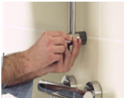
Glissez les caches bas et haut sur les embouts en plastique gris foncé de manière à aligner les rainures des 2 éléments.
