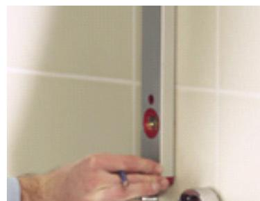
Avec un crayon, marquez les intersections des carreaux les plus proches des fixations de la barre tout en vérifiant la verticalité.
