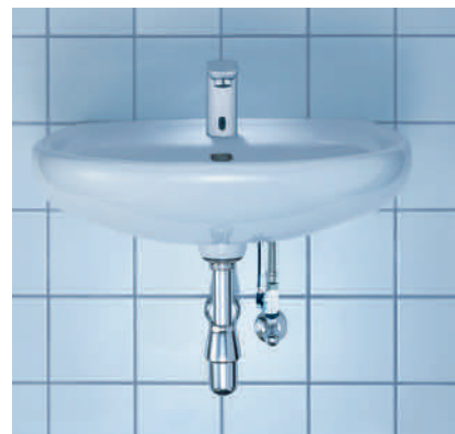
Pile et électrovanne montées sous le lavabo pour un entretien aisé
