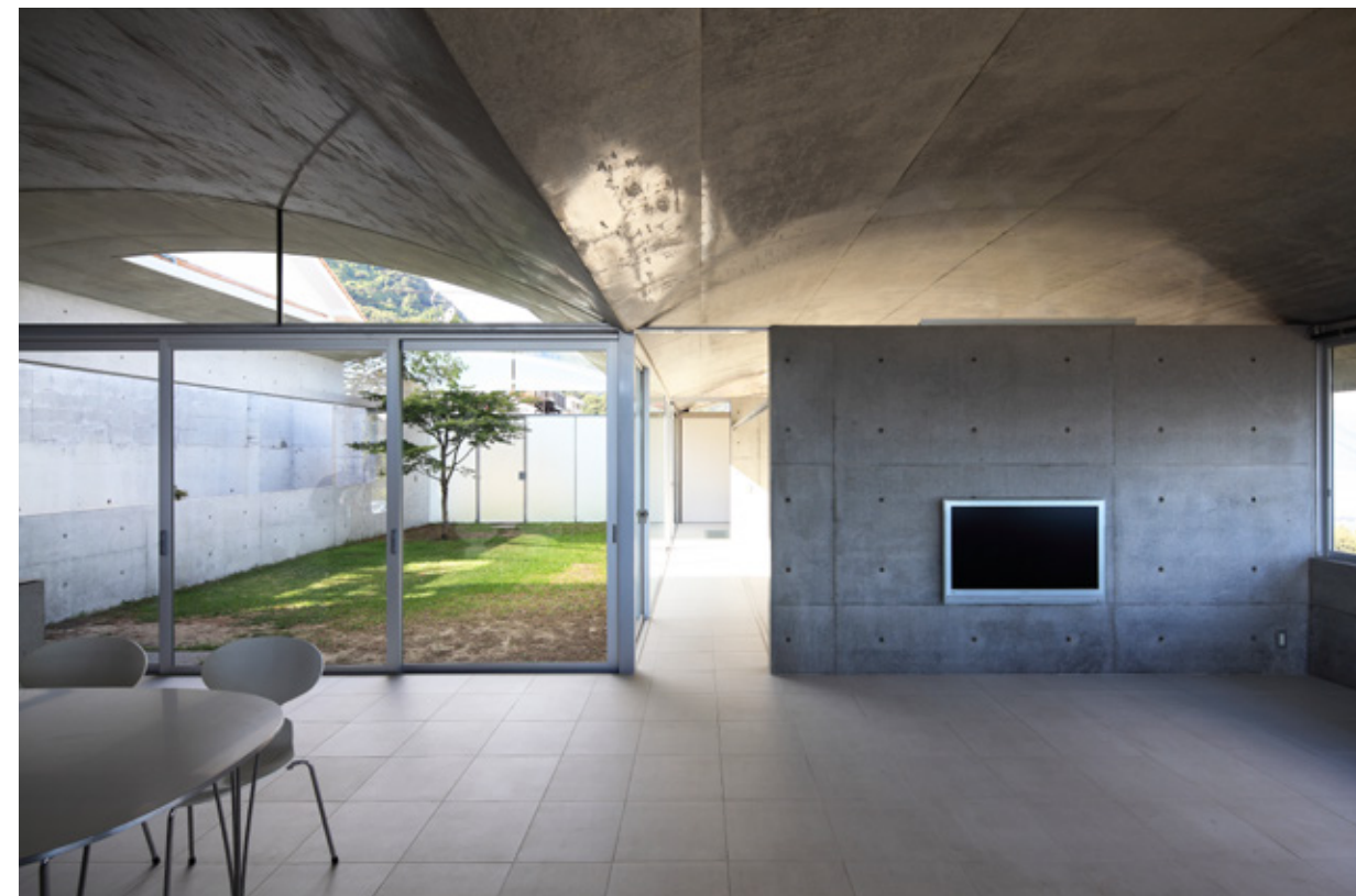
Die Wände in Fujimotos Sunami House sind allesamt unverputzt. Die kleinen Löcher sind Spuren der Abstandhalter, die bei den Betonarbeiten verwendet wurden.
